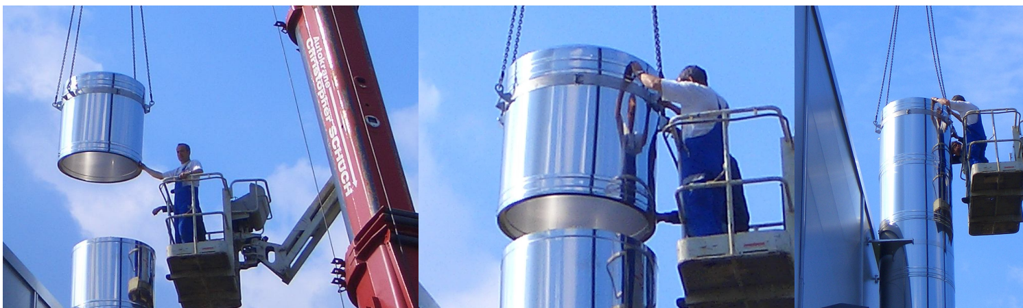
Рис. 22 Пример монтажа при помощи приспособления
